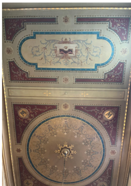
◀ Plafond de la Chapelle de la Vierge
